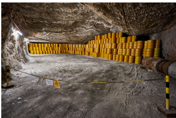
Einlagerungsbereich für Abfallbehälter
